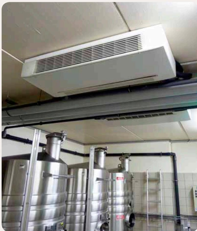
**Les systèmes centralisés** peuvent climatiser la totalité du bâtiment ou plusieurs pièces. Ces systèmes nécessitent un dimensionnement frigorifique plus important. On retrouve par exemple le multi-split, qui est un équipement évolutif basé sur le split-système et les pompes à chaleur réversibles, qui peuvent alimenter des ventilo-convecteurs, des planchers rafraîchissants ou des réseaux de distribution par gaines de soufflage.
